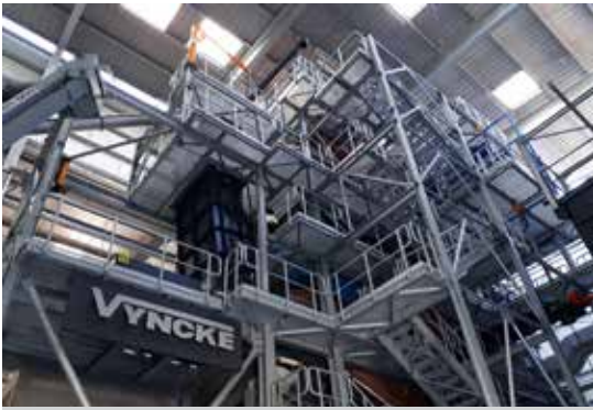
La chaudière de l'usine a été installée durant l'été.
